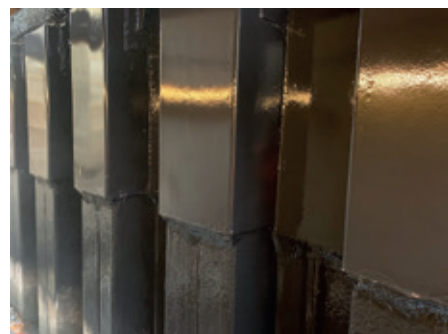
Foto 2: Aangebrachte Humidur coating op een stalen oppervlak in maritiem milieu.
