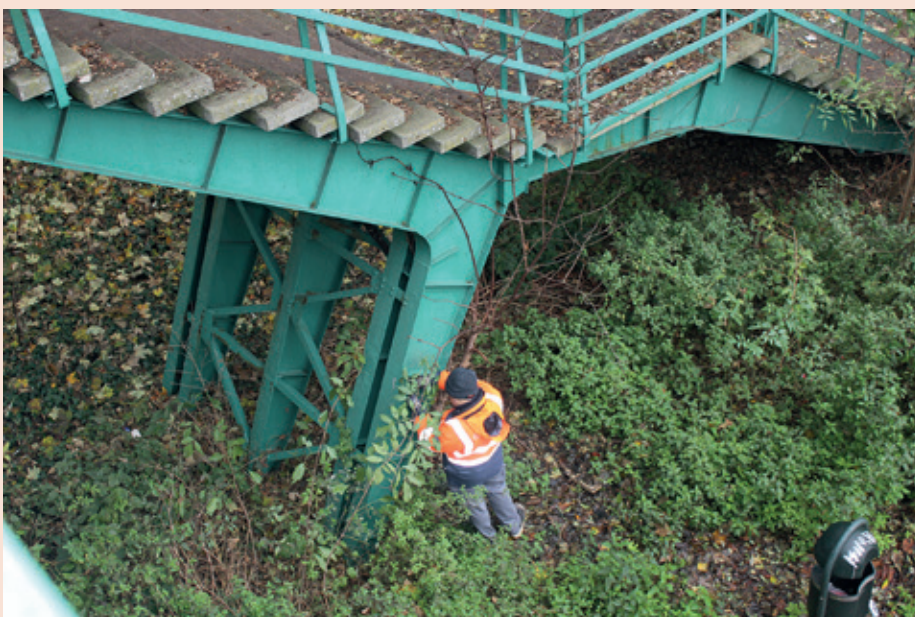
▲ Inspection d'un pont et prélèvement de peinture
