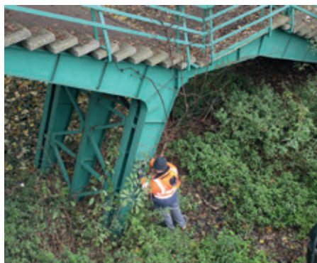
Bruginspectie en staalname van verf-schilfers
