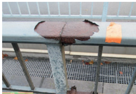
Afbladeren van de verf en corrosie op een brugbalk
