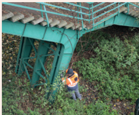
Inspection d'un pont et prélèvement de peinture
