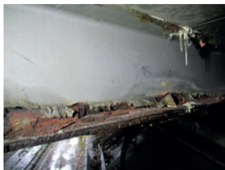
Afbladeren van de verf en corrosie op een brugbalk
