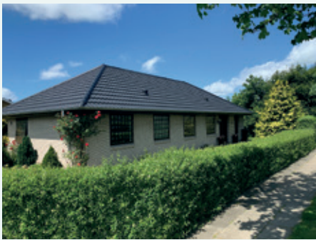
Installation de Tuiles Métalliques AeroDek : Images montrant des tuiles métalliques AeroDek installées sur un toit.
