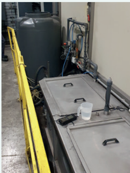
Procédures de Traitement de Surface : Photo de l'intérieur de l'usine montrant les machines et procédés de traitement de surface.
