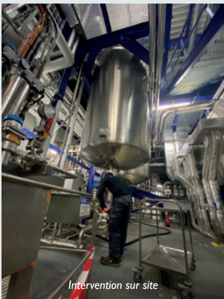
Intervention sur site
