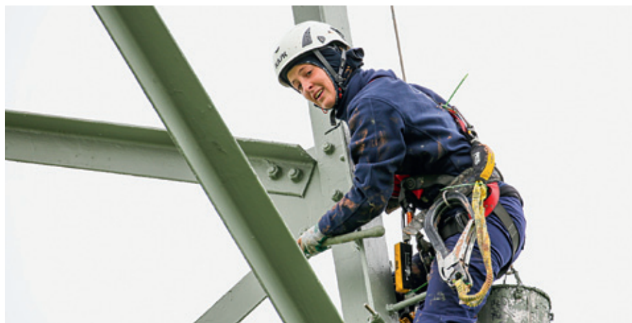
Werken in hoogspanning met de juiste valbeveiliging
