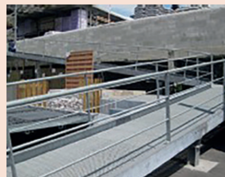
PHOTOS 3+4 Un aperçu des réalisations de Galvaco.
