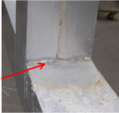
Foto: voorbeeld van een slecht afgewerkte lasnaad
