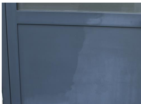
Foto 1: voorbeeld van half gereinigd oppervlak
