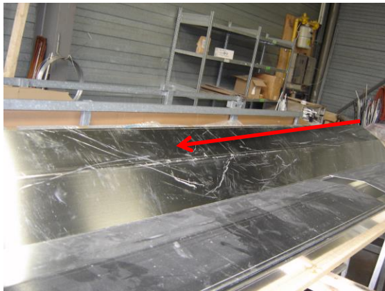
Foto: ernstige krassen in de aluminium plaat omwille van onzorgvuldig transport. Deze krassen blijven zichtbaar door de laklaag.
