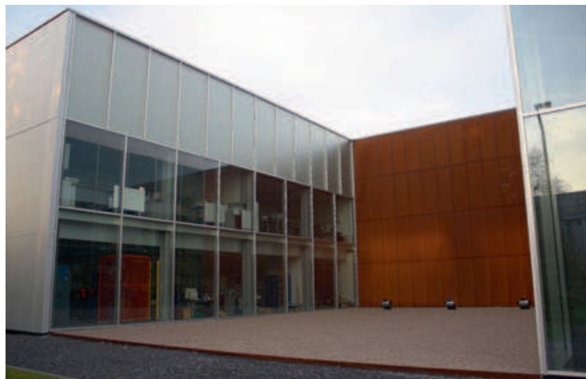
Weervast staal gebruikt als gevelbekleding bij MRC te Gent
