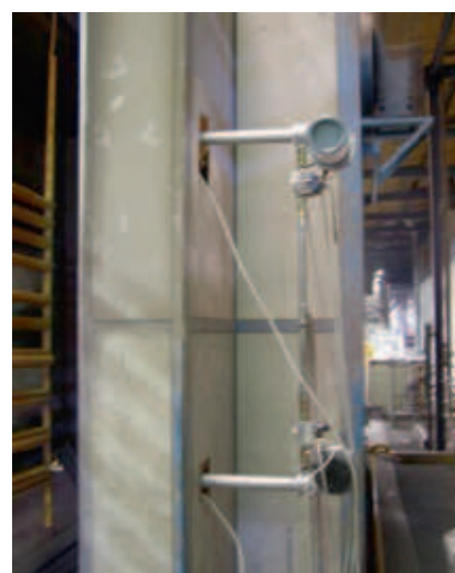
Foto 8: boven de rechter boosterhelpt aan de ingang van de infrarood oven met katalytische emitters; onder de compacte gas/lucht mengsystemen
