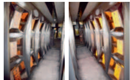
Foto 5: poederlaklijn met infrarood insmeltzone met retrofit metaalvezelbranders, links laag vermogen rechts hoger vermogen
