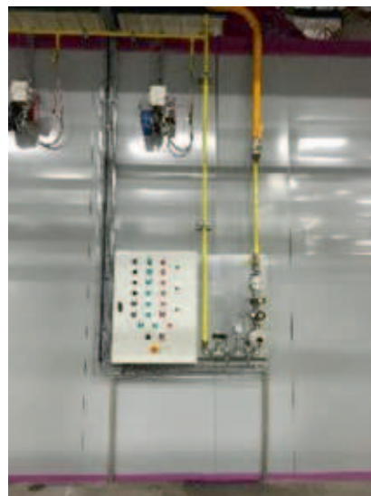
De montage van de draagstructuur, de emitters, de gas/lucht mengunits en stuurkast
