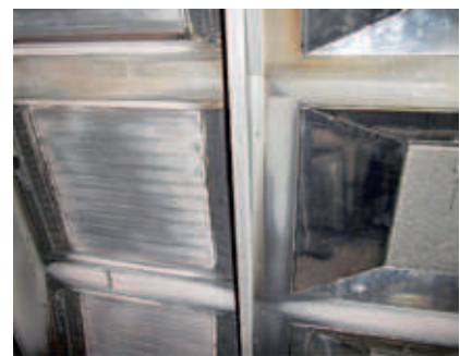
Foto 4: links de katalytische emitters en rechts de retrofit metaalvezelbranders
