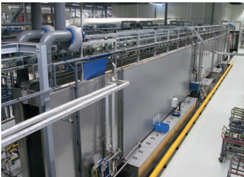
Geïsoleerde sproeitunnel afvalwatervrij
