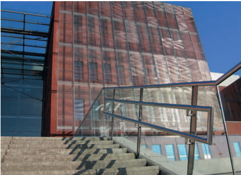
Figuur 2 - Gevelbekleding en leuningen, elektrolytisch gepolijst. Voor buitentoepassingen is elektrolytisch polijsten de standaard geworden door de hogere corrosiebescherming.
