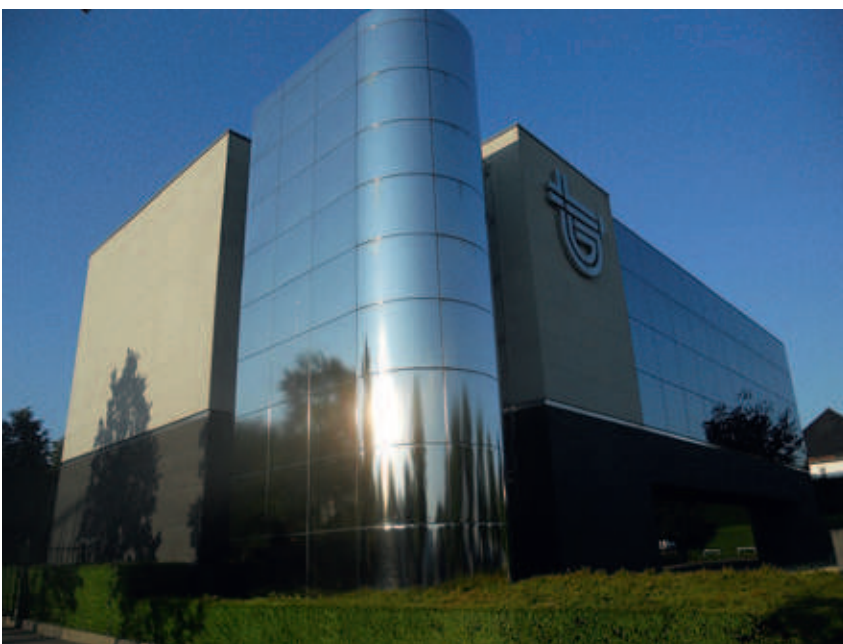
Figuur 3 - Elektrolytisch gepolijste gevel, intact na meer dan tien jaar.
