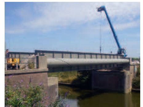
Een oude spoorwegbrug uit WOII werd recent gerenoveerd als fietsbrug met een Polysiloxaan als toplaag
