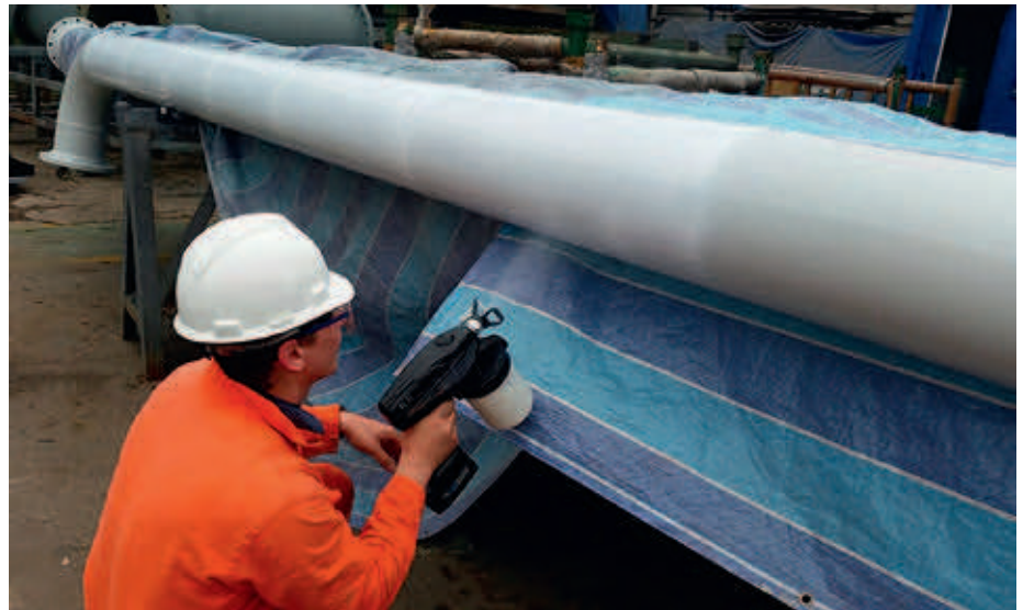
▲ Aanbrengen van HS Protect op buiswerk
