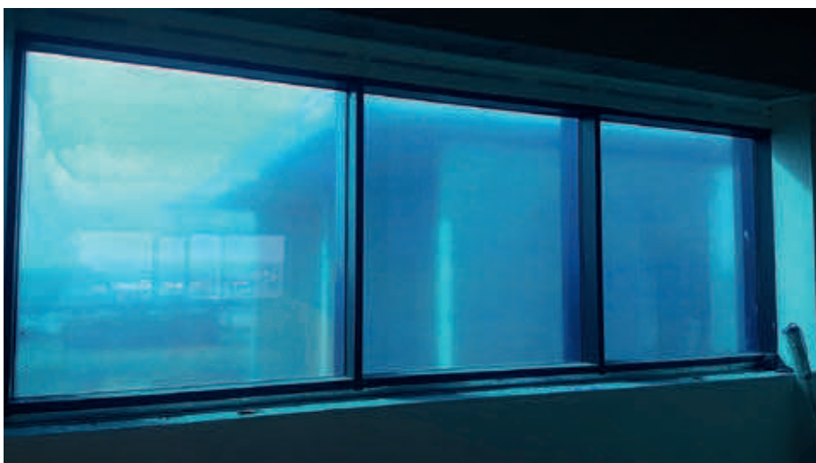
▲ Bescherming van vensters tijdens bouwwerken
