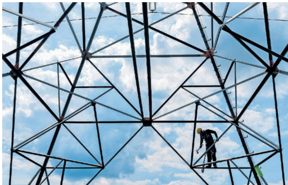
▲ De hoogspanningsmasten in Schijndel worden geschilderd
