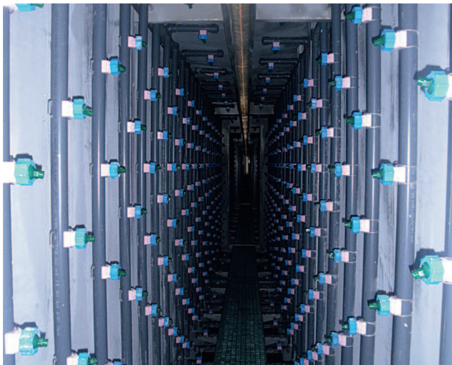
▲ Installatie na de reiniging
