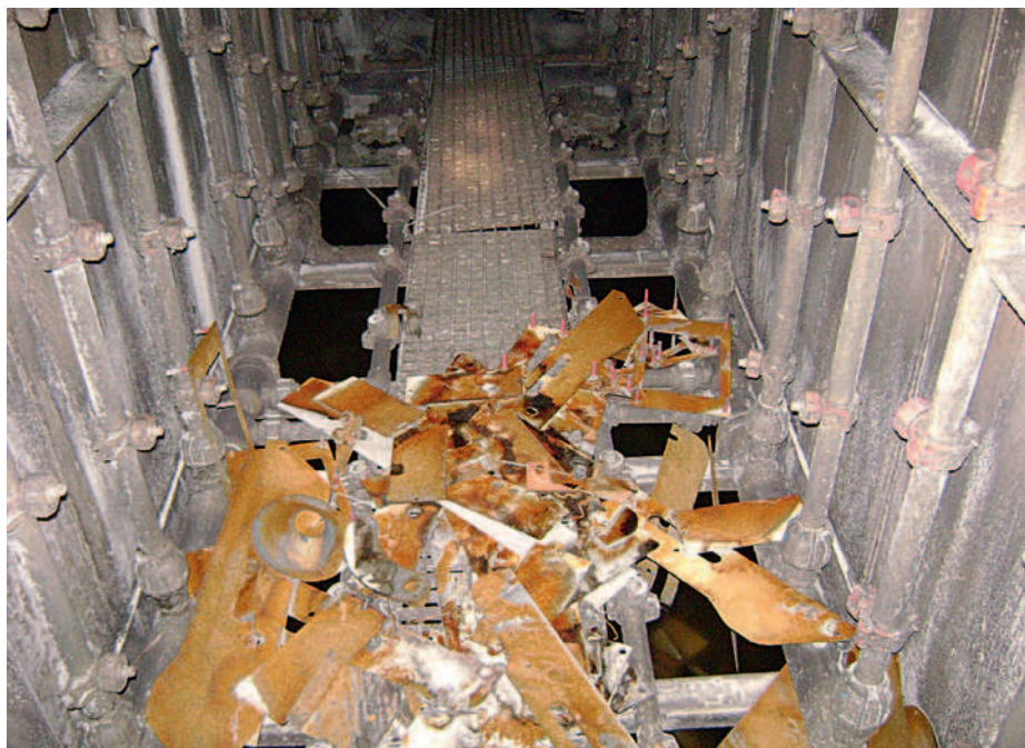
▲ Installatie voor de reiniging
