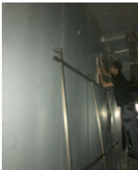
Foto 10: de montage van de draagstructuur de emitters, de gas/lucht mengunits en stuurkast
