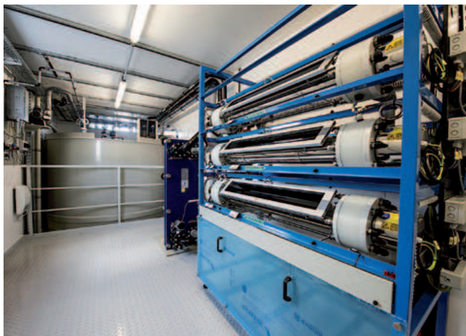
Foto: voorbeeld van een Envirochem® AOP installatie op basis van UV / H2O2
