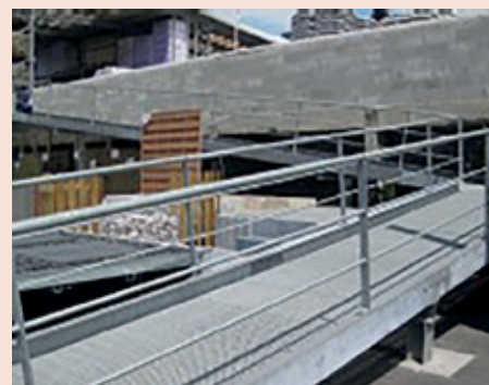
PHOTOS 3+4 Un aperçu des réalisations de Galvaco.
