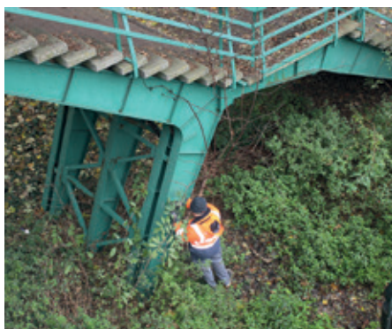
▲ Bruginspectie en staalname van verfschilfers
