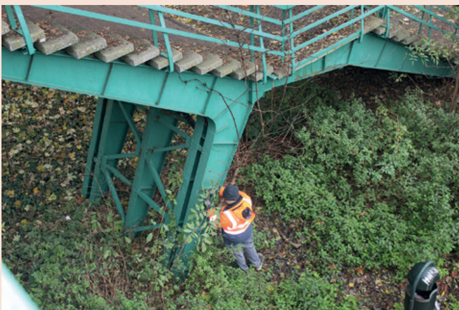
▲ Inspection d'un pont et prélèvement de peinture
